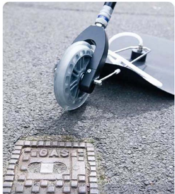
Dokładne wykrywanie wycieków to kwestia bezpieczeństwa
