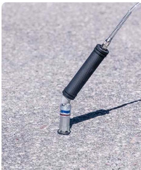
Próbki gazu są pobierane z otworów, aby zidentyfikować lokalizację najwyższego stężenia.
